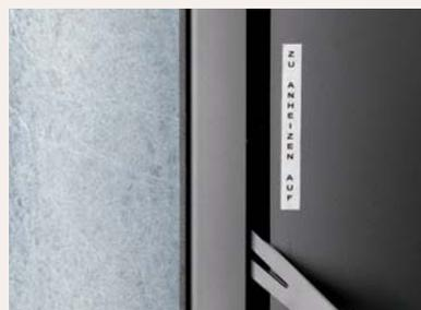
Um nach dem Anheizen möglichst schnell die optimale Brennraumtemperatur zu erreichen, wird die Anheizklappe geöffnet. Die Abgase strömen ohne großen Widerstand an dem Wärmetauscher vorbei. Dadurch entsteht ein höherer Zug und somit eine stärkere Sauerstoffzufuhr.
